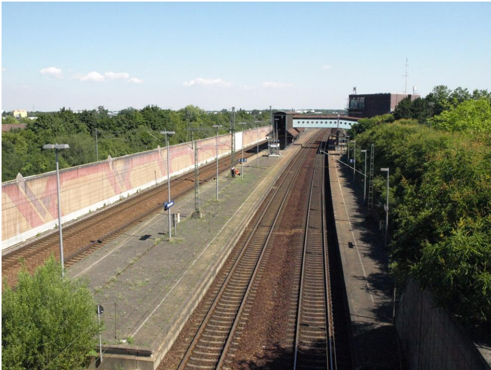
Foto 3 - Von Brücke auf Bf. Hockenheim (Abschnitt Raumgitterwand) - Blickrichtung: nord
